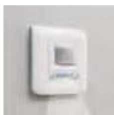
str. 49 Detektor pokreta sa LED sijalicama za osvetljavanje poda
